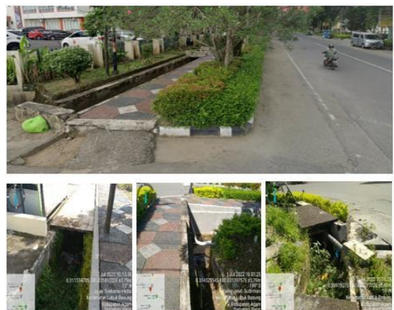
Gambar 13. Kondisi saluran di Jl. Soekarno Hatta tidak hujan
