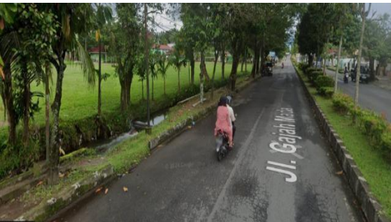
Gambar 15. Kondisi saluran di Jl. Gajah Mada tidak hujan
