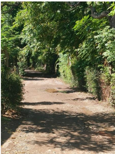
Gambar 29. Gambar Jalanan Berlubang (Sumber: Dokumentasi Pribadi)
