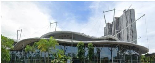
Gambar 2. Tampak penerapan struktur bentang lebar bersistem kabel dengan tiang penunjang. (Sumber: Analisis Pribadi)
