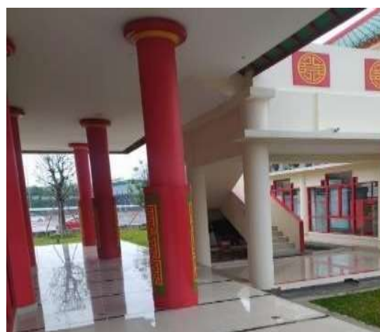
Gambar 43. Pilar Pelataran Masjid Sumber: Dokumentasi Pribadi, 2020
