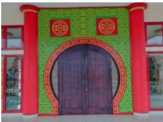
Gambar 41. Pintu Masuk Utama Sumber: Dokumentasi Pribadi, 2020
