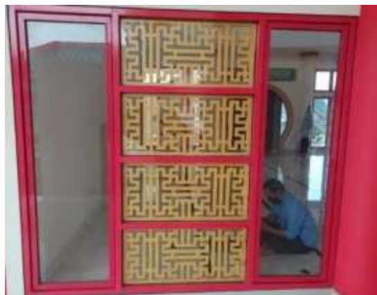
Gambar 42. Jendela Sumber: Dokumentasi Pribadi, 2020
