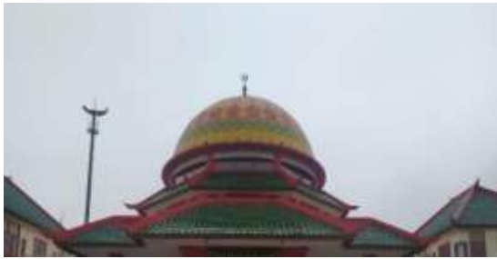
Gambar 52. Atap Masjid Sumber: Dokumentasi Pribadi, 2020
