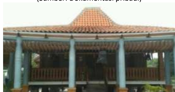
Gambar 5. View fasade rumah joglo Betawi (Sumber: Dokumentasi pribadi)
