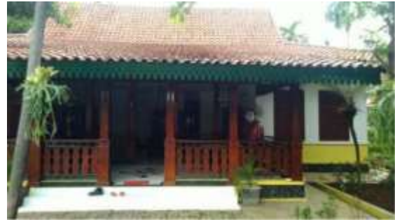
Gambar 2. View fasade rumah kebaya (Sumber: Dokumentasi pribadi)
