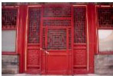
Gambar 4. Pintu dan dinding
