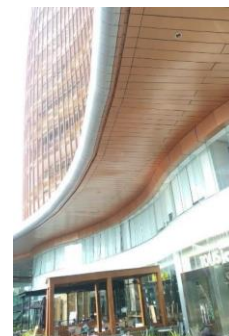
Gambar 4. Area retail gedung perkantoran South Quarter Jakarta Sumber: Dokumentasi pribadi
